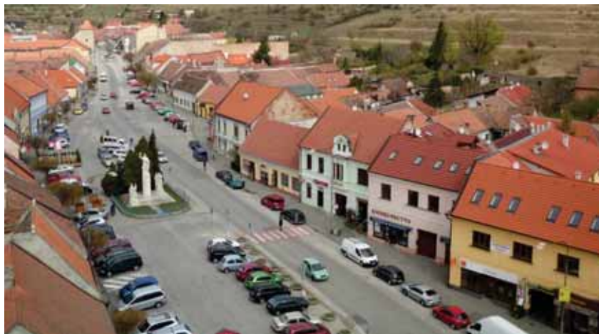
obr. 1: námestie – súčasný stav zdroj: [5]
