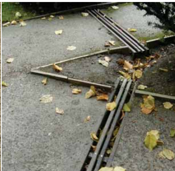
obr. 11: Odvodňovací drevený žľab v mlatovom povrchu chodníkov, Český Krumlov, 2011
