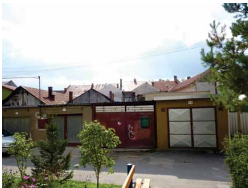
obr. 14: Sabinov, garáže za dvorovými traktami domov z Námestia slobody zdroj: archív KPÚ Prešov
