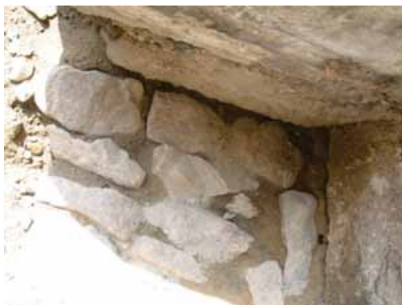
obr. 10: nález pôvodnej štetovej dlažby v prejazde Hornej brány (2013) zdroj: archív J. Gregorovej
