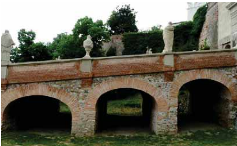
obr.6: Hradný most - po rekonštrukcii
