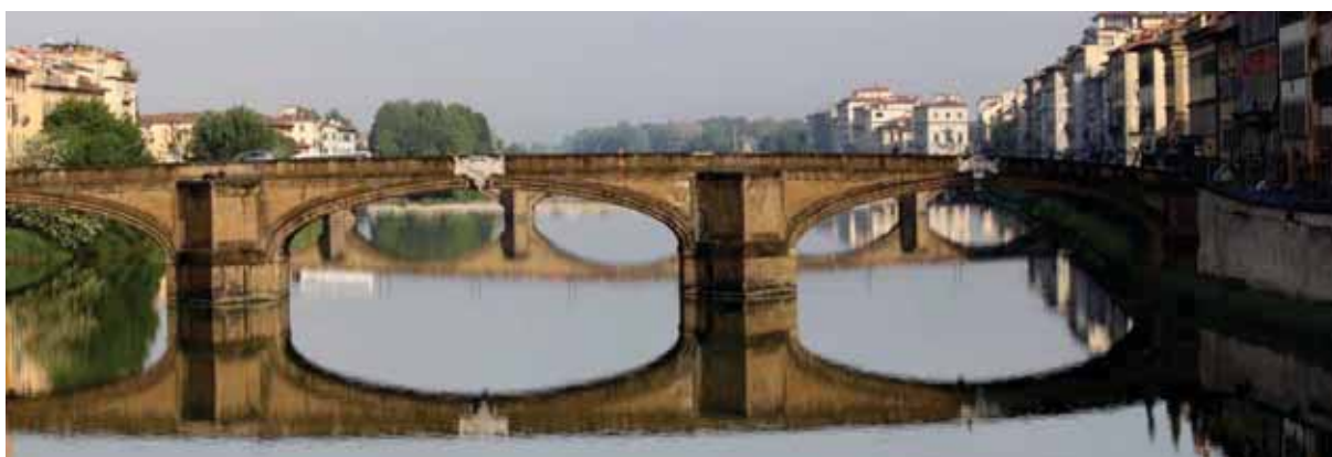
obr. 18: Most Ponte st.Trinita - súčasný stav
