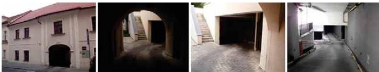
obr. 9 - 12: meštiansky dom na Panenskej ulici v Bratislave statická doprava riešená formou podzemnej garáže s rampou zdroj: foto archív autorky
