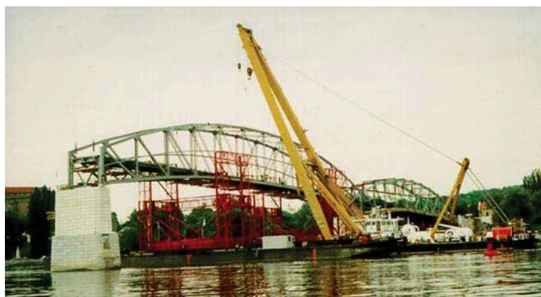
obr.2: Most Márie Valérie - počas rekonštrukcie
