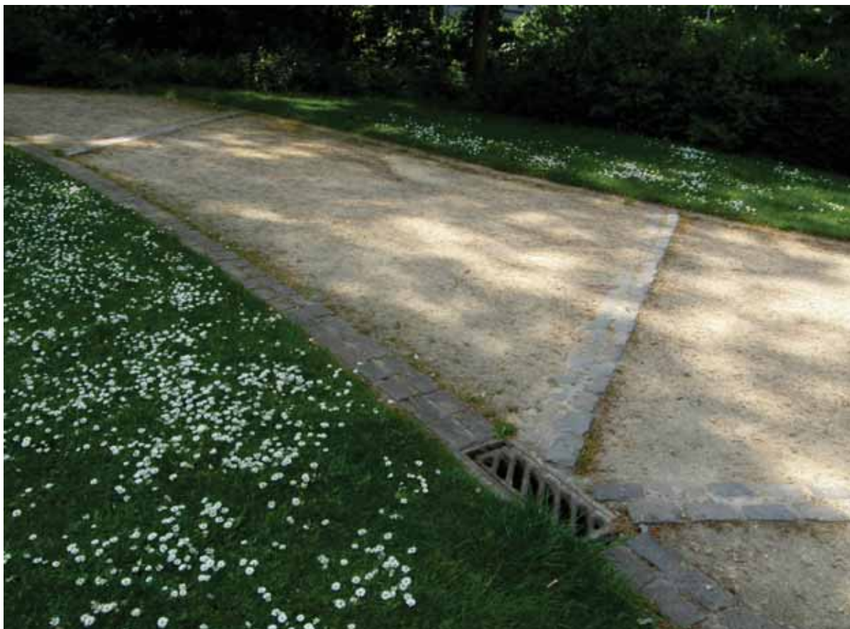
obr. 3 Mlatový chodník prekladaný kamennou kockou vo svahu a odvodnenie chodníka. Brusel 2014
