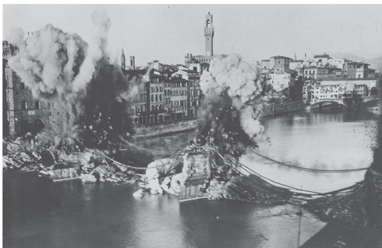
obr.17: zničený Most Ponte st.Trinita (8.8.1945)
