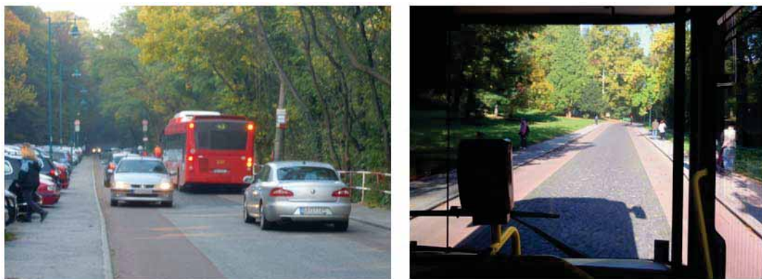
obr. 7: Obojsmerná miestna komunikácia s nadrozmenrným viacúčelovými pruhom v Bratislave zdroj: fotografie-autor
