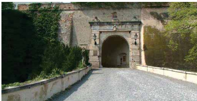
obr.4: Hradný most - pred začatím rekonštrukcie
