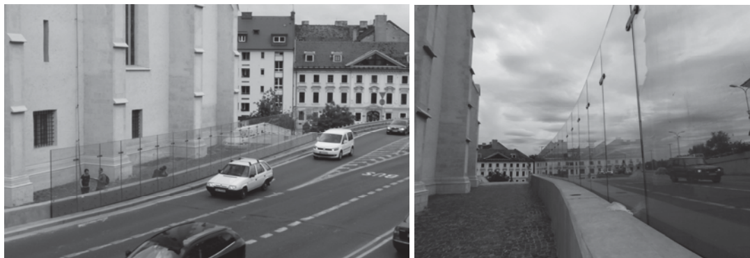
obr. 6: Ochranná presklená stena pred emchanickým znečistením fasády Dómu sv. Martina z dopravy.
