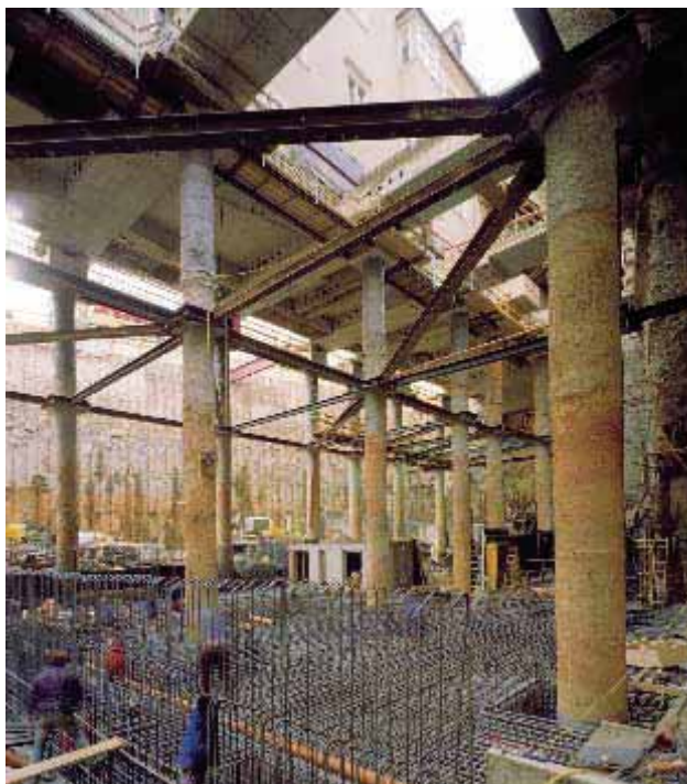
obr. 2: Podzemné garáže v Grazi, podchytenie celej budovy paláca pri výstavbe podzemnej garáže, 2003. zdroj: Tiefgarage Kastner + Öhler Graz, foto © Angelo Kaunat, http://www.zement.at/Service/literatur/fileupl/kasteruoeler_tiefgarage02_05.pdf
