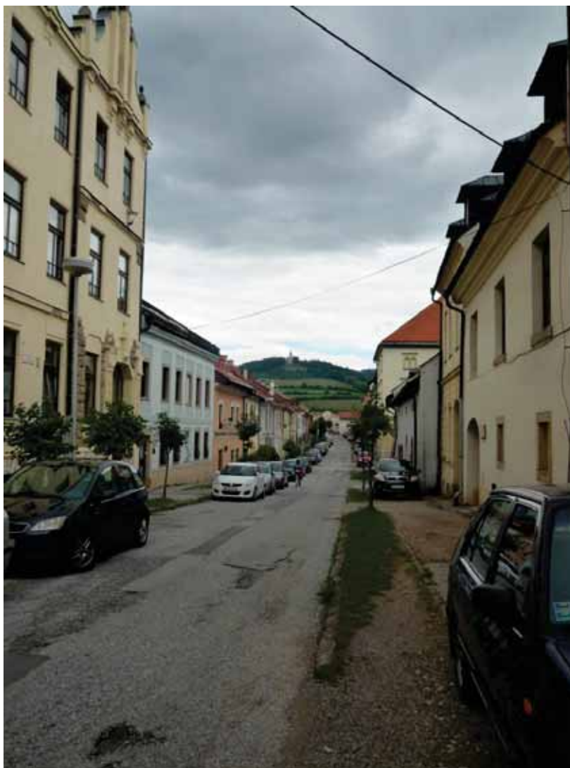
obr. 3: usporiadanie ulice s chodníkmi po oboch stranách, s líniovými pásmi a v strede s vozovkou zdroj: archív KPÚ Prešov
