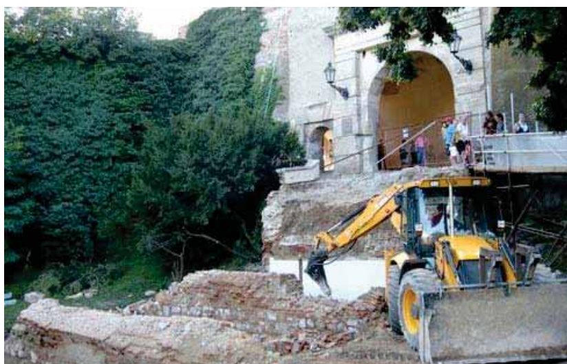
obr.5: Hradný most - počas rekonštrukcie
