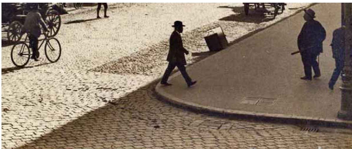
obr. 16: Košice na rohu Hlavnej a Alžbetinej (okolo r. 1914) – asfaltový chodník a rôzne typy dlažieb zdroj: poskytla arch. A. Hrabinská
