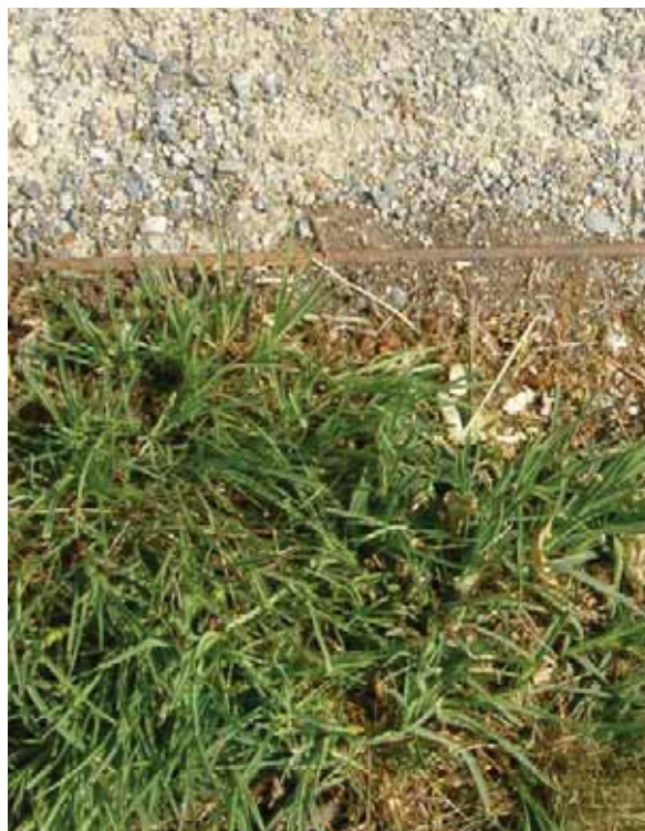
obr. 6: Oceľová pásovina nahradí obrubník
