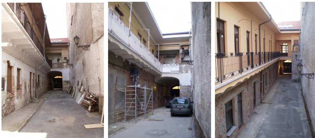
obr. 9: Obnova dvorového krídla domu na Kováčskej 22 – stav pred obnovou v roku 2008 – počas v roku 2009 – a po ukončení obnovy 2.NP a pavlače v roku 2010
