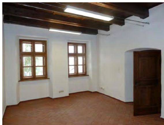
obr. 6: Obnovený interiér na 2.NP s priznanými reverzibilnými novotvarovými svietidlami spĺňajúci hygienické požiadavky pre osvetlenie učební zdroj: foto autor
