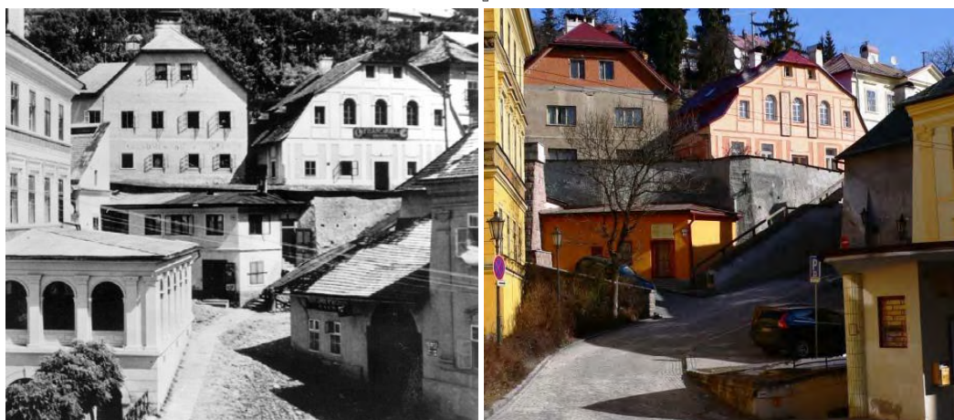
obr.3,4: V priebehu približne 60. – 80. rokov 20. storočia došlo k postupnému zániku autenticity prostredia Radničného námestia. V 80. rokoch 20. storočia sa presadzovali názory na „očistenie“ vnútromestských priestorov od menších, „architektonicky nehodnotných“ stavieb.
