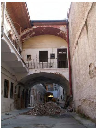
obr. 8: Obnova výplní priečného krídla – stav pred – výsledky výskumu – po zamurovaní nevhodných výplní a osadení nových výplní
