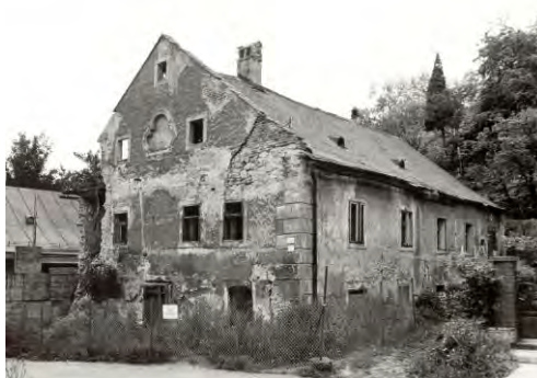
obr. 11: Východisková situácia stavebno-technického stavu domu pred obnovou. Rok 1991.
