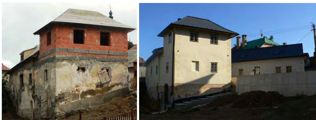
obr. 16,17: Pohľad na nárožie domu v priebehu obnovy a po obnove. Z priebehu obnovy je zrejmé, že pôvodne drevená zrubová konštrukcia „veže“ bola odstránená a nahradená novou tehlovou. Závažnejšia je však zmena tvaru strechy na plytkú valbovú nad vežovou časťou. Pri stanovení metodiky neboli pochopené prevládajúce hodnoty pamiatky – pôsobenie hmoty v dome v obraze mesta.
