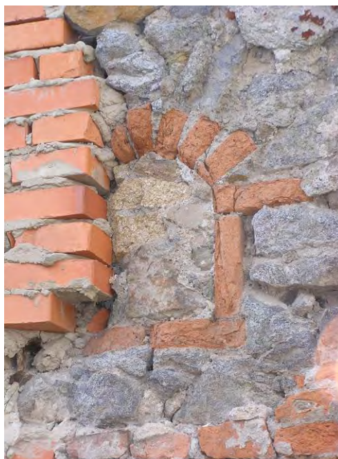
obr. 3: Pri záchrane torza domu stavebná firma pracovala v mierke ktorá nerátala s detailmi. foto: Michal Hrčka, 2002.
