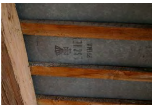
Obr. 9: pozinkovaný plech TESCHEN PRIMA (r. kat. kostol v Prešove-Šalgovíku)
