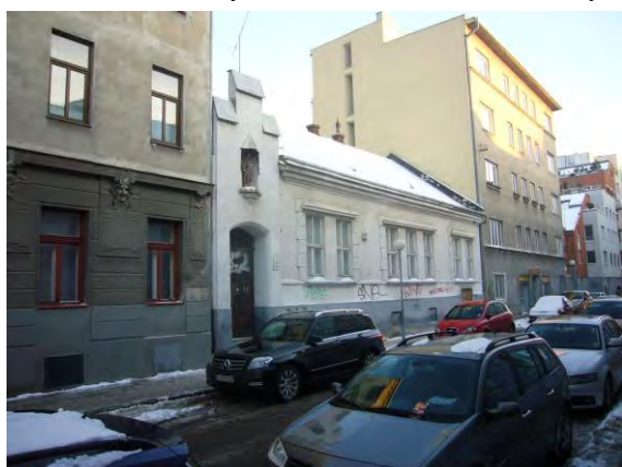
objekt pred obnovou
