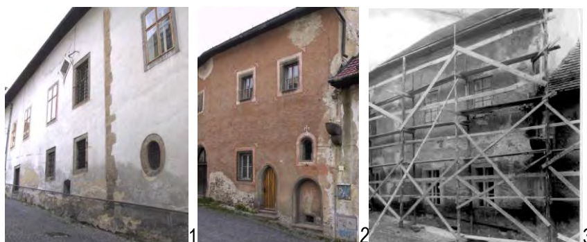
obr. 8: Pohľad na časti severnej fasády na Kollárovej ul. – 1: západná časť s nárožím najstaršej stavby, 2: východná časť s reštaurovanou fasádou z 2. pol.15. storočia, 3: v r. 1959 v čase reštaurátorského výskumu.
