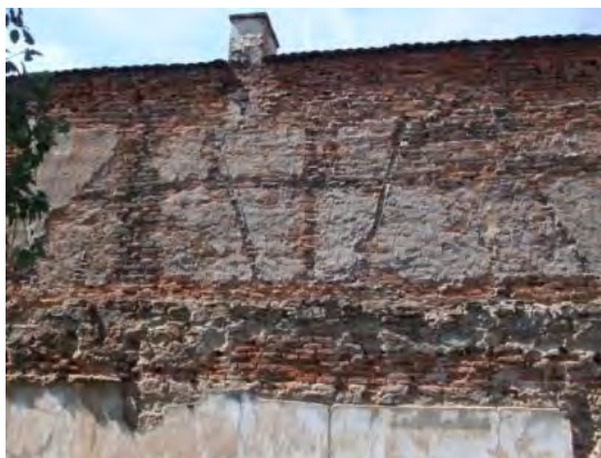
Obr. 12: PO, Hlavná 49, dvor. krídlo (negatív po hrebeňovej stolici s horiz. rozperou)
