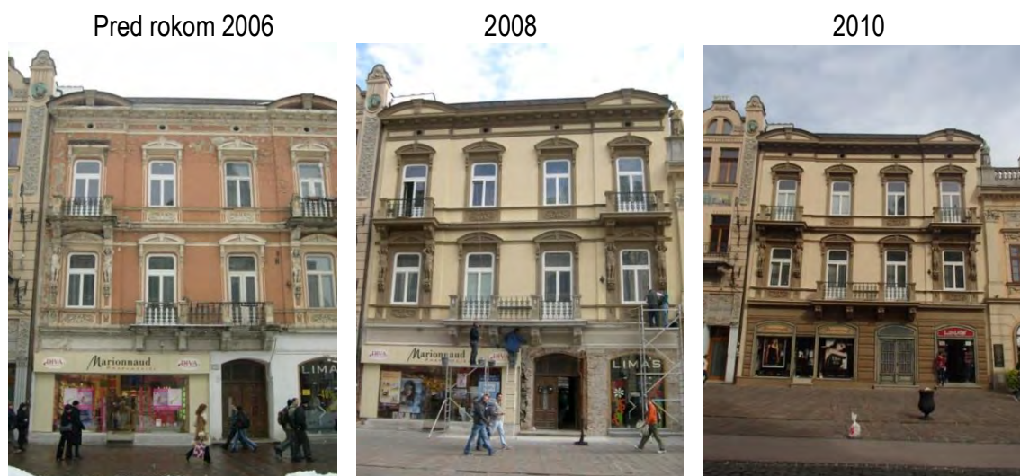
obr. 4: Pohľady na uličnú fasádu pred, počas a po reštaurovaní zdroj: KPÚ Košice
