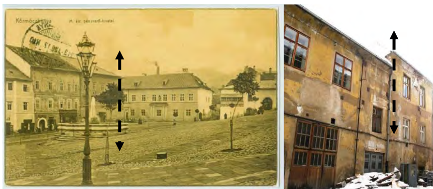
obr. 11: Podhľad na mincovňu na dobovej fotografii pred rokom 1918 ( 1912-13?) s vyznačením západného domu a pohľad na západnú dvorovú fasádu s vyznačením východného domu.
