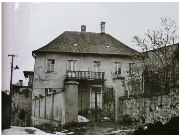
obr. 1: Čelná fasáda objektu z roku 1980 zdroj: Archív PÚ Bratislava
