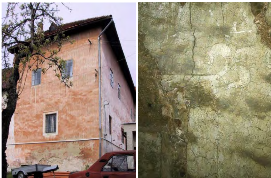
obr. 9: Pohľad na južnú dvorovú fasádu a východnú dvorovú fasádu 1-traktovej stavby, kde pod súčasnou fasádou sa predpokladá nálež úpravy fasády nielen z 2. polovice 15. storočia ale aj zo staršej etapy. Pohľad na originál nálezu z 2. pol.15. storočia.
