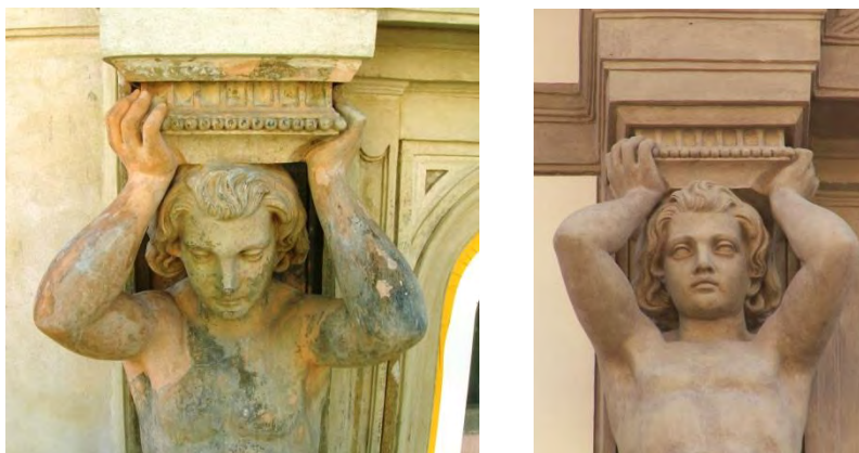
obr. 3: Terakotové postavy atlantov – počas reštaurovania, po domodelovaní chýbajúcej ruky a po finálnom farebnom riešení zdroj: KPÚ Košice
