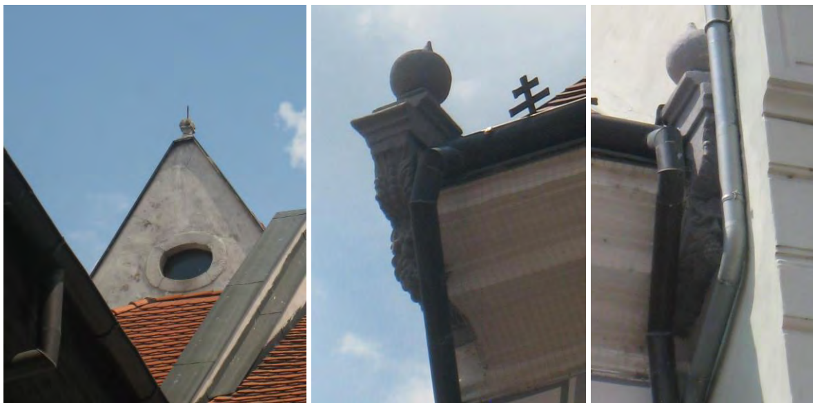
obr. 10: Štít v časti severného krídla s kamennými prvkami výzdoby
