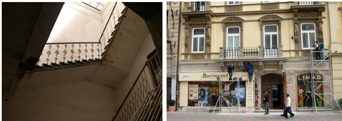
obr. 2: Reprezentačné trojramenné schodisko v hlavnom krídle domu a obnova parteru v roku 2006 zdroj: KPÚ Košice
