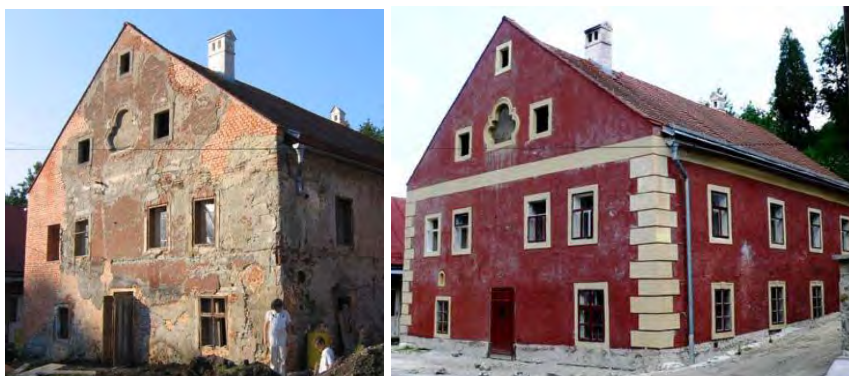
obr. 12,13: Stav domu pred obnovou a po obnove s detailom niky v štíte pred a po reštaurovaní.
