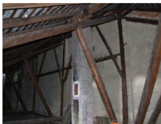
Obr.10: PO, Hlavná 112 (stolica s horiz. rozperou)
