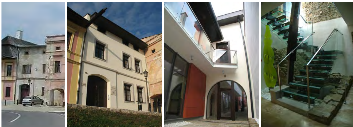
obr. 12,13,14,15: Rekonštrukcia domu v Spišskej Sobote – pôvodný stav uličnej fasády, uličná fasáda po rekonštrukcii, nádvorie objektu s novou prístavbou, novotvar schodiska
