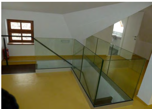
obr. 3: Schodisko do podkrovia – priznanie novotvaru skleneného zábradlia
