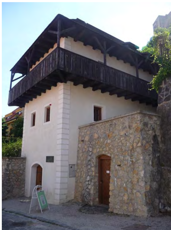
obr. 6: súčasný stav Katovho domu (2013)
