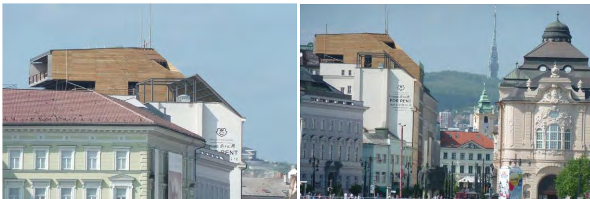
obr. 3: Nadstavba domu na Mostovej č. 4 – 6.
