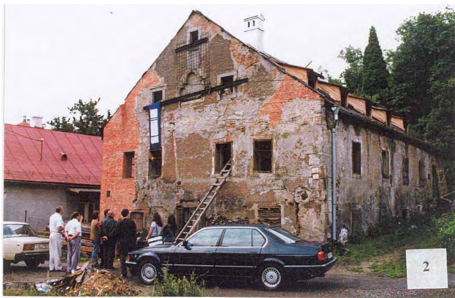
obr. 2: Dom po domurovaní výrazných úbytkov muriva a výmene krovu. Roky 1996-1997. zdroj: foto archív Spolku Banskéj Štiavnice '91.
