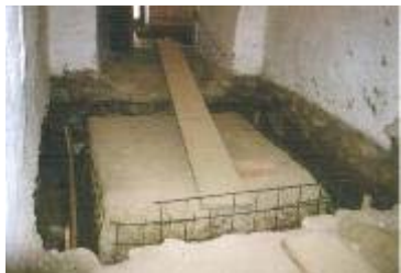
Betonáž kanála v podveží
