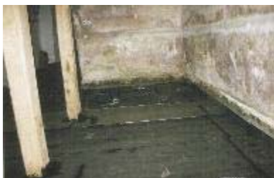
Hydroizolácia podkladného betónu
