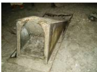
Historický kovový svetlík, ktorý slúžil ako podklad pre vyhotovenie kópii
