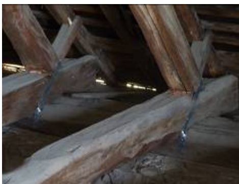
Bardejov – ev av kostol – obnova z roku 2009 – opásanie strmeňmi uvoľnených spojov (krokva-väzný trám-pomurnica)
