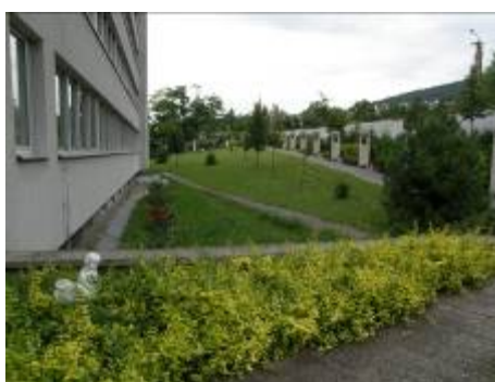
Ukážka úpravy krížovej cesty pri bývalej budove Agrokomplexu, dnes rehoľný
