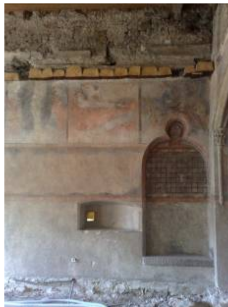
Interiér kaplnky po odstránení drevenej trámovej konštrukcie. Foto: Ing.arch. O. Strýček
