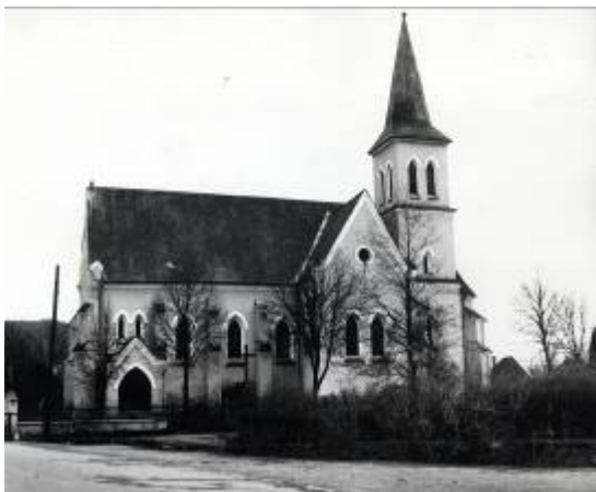
Raková, r.k. kostol – pohľad západný stav k roku 1954 autor Kovačevičová, archív PÚ SR č. 2708_1
