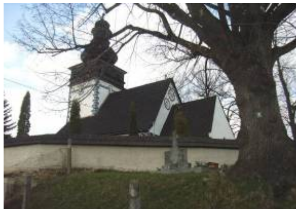
Bočný pohľad na areál Kostola po zreštaurovaní
