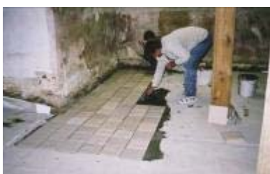
Pokládka ručnej keramickej dlažby
