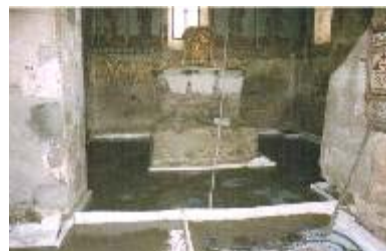
Betonáž temperovanej mazaniny
