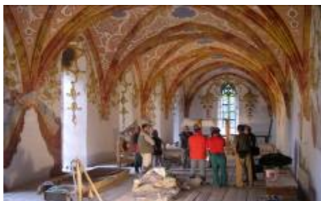
Červený Kláštor, kostol, reštaurovanie v etape po znížení lešenia. P. Glos
