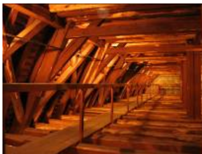
Bratislava - Dóm sv. Martina – pohľad do krovu s ležatými stolicami nad svätyňou (prvky opatrené bordovým náterom v 90. rokoch 20. storočia)
