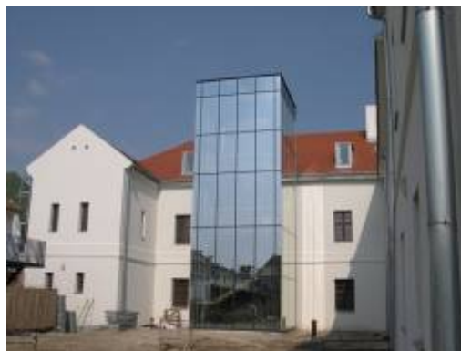
Dvorová fasáda kláštora po obnove, s priznaným novým komunikačným jadrom
