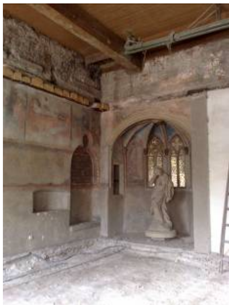
Interiér kaplnky po odstránení drevenej trámovej konštrukcie. Foto: Ing.arch. O. Strýček
