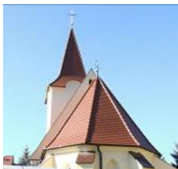
Vyšná Šebastová – rímskokatolícky kostol sv. Kataríny – pohľad na kostol po obnove (revitalizácii pôvodných tvarov striech)
