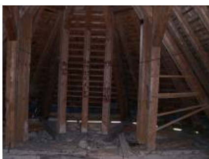
Sedliacka Dubová, r.k. kostol – krov nad loďou poškodenie krokiev v úrovni väzných trámov a výmen stav k roku 2009 autor Ing. arch. Karol Ďurian
