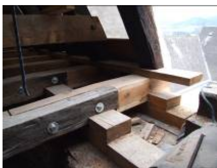
Okoličné – r.kat kostol sv. Petra z Alkantary – obnova z roku 2010 poškodených trávov krovu (zhlaví) nad korunou muriva protézami (pomurnica - väzné trávy)
