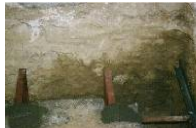
Oceľ. konštrukcia pre strop kanála
