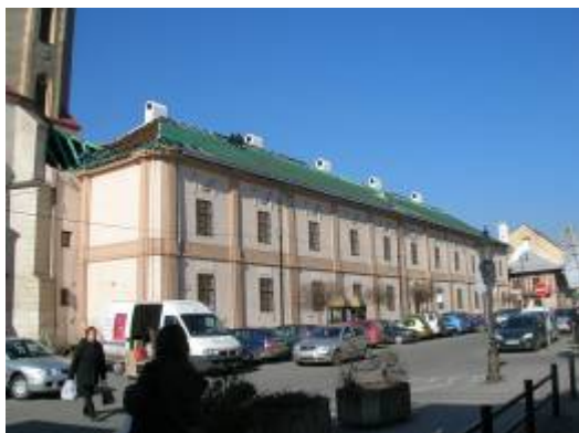
Východná uličná fasáda kláštora pred obnovou v roku 2006
